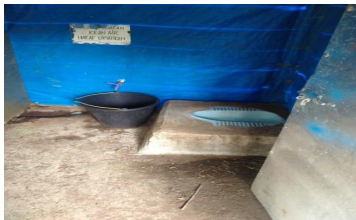
Gambar 2. Kondisi WC Sumber: Dokumen Penelitian 2021
