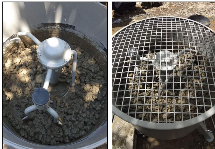
Gambar 11. Pengadukan Material Bahan Pembuatan Beton
