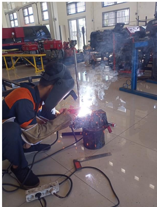
Gambar 51. Pengelasan Plat Pencekam dan Poros
