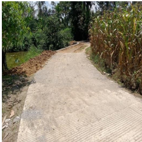
Gambar 1.1 Pembangunan Jalan Usaha Tani yang Belum Selesai
