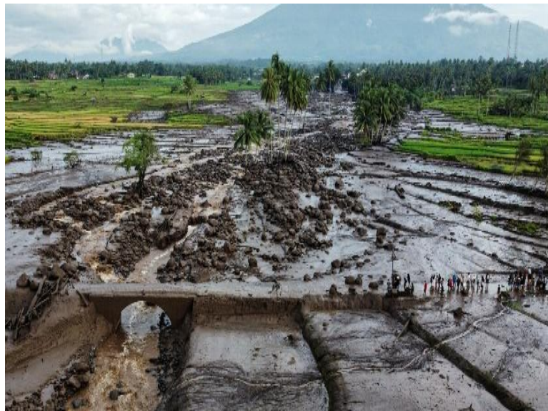
Gambar 2. Kerusakan akibat Galodo di Nagari Sungai Jambu (Sumber: Arosukapost.com, 2025)
