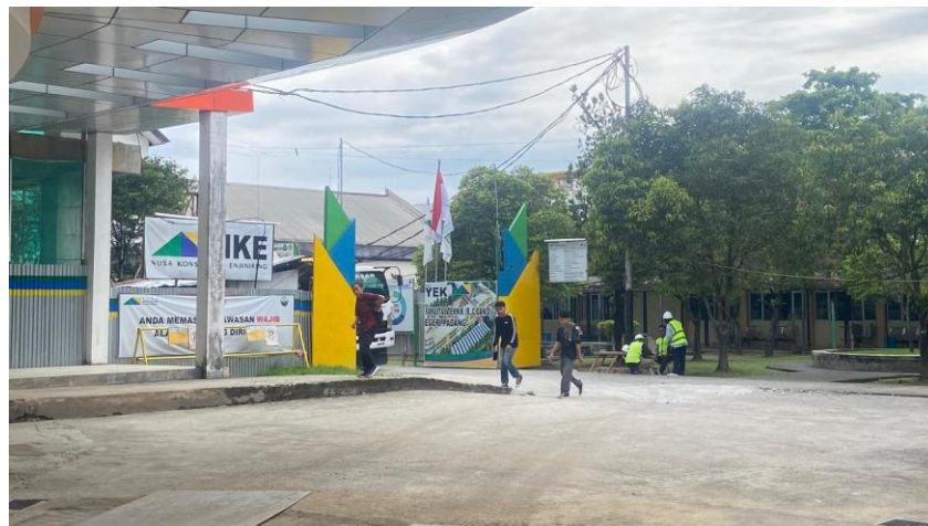
Gambar 4 Gerbang Proyek di Area Gedung Dekanat Sumber : Dokumentasi Pribadi, 2025
