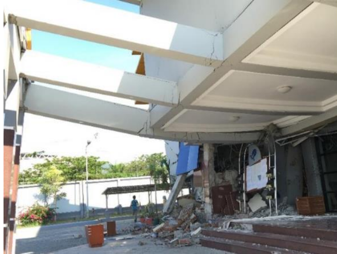
Gambar 4. Lendutan yang Terjadi pada Balok (Sumber : Tampubolon et al, 2022)
