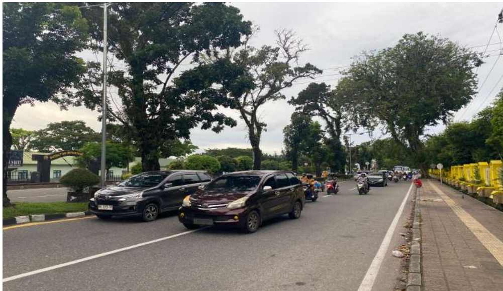
Gambar 2. Kondisi Eksisting Jalan di depan Gerbang UNP Sumber: Hasil Observasi Lapangan
