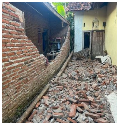
Gambar 2. Rumah Rusak Akibat Gempa 4,4 Magnitudo di Kota Pekolanan Sumber: Redaksi, SIN PO.id, 2024 (URL: http://surl.li/zmnpjm )
