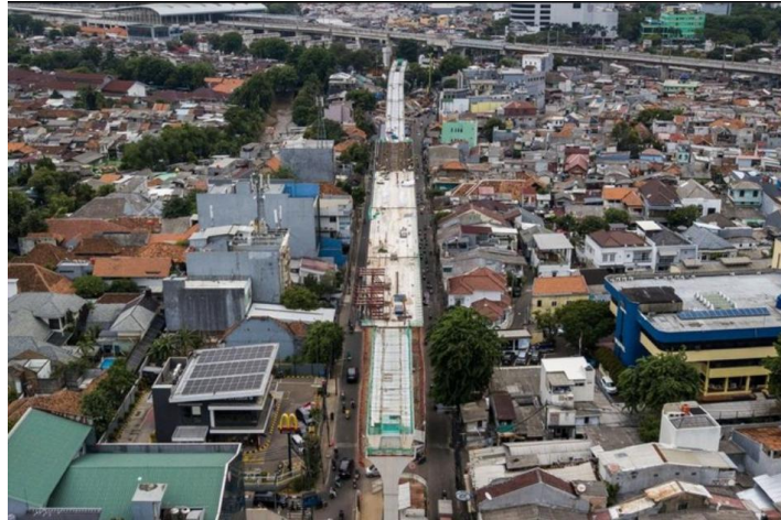
Gambar 1. 2 Konstruksi LRT Jakarta Fase 1B di Pemukiman Penduduk Sumber : Data Proyek
