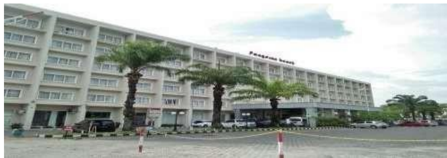
Gambar 3.5 Parking Area Sumber: Dokumentasi pribadi
