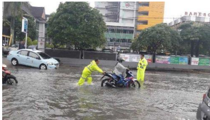
Gambar 2. Kondisi penurunan sistem drainase di Jalan Jenderal Sudirman, Kota Pekanbaru
