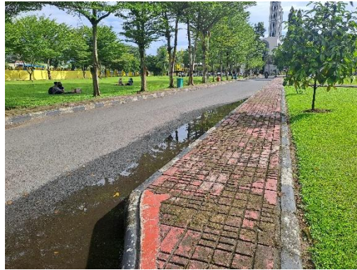
Gambar 2. Trotoar yang tidak memiliki ramp, jalur pemandu dan sempit (Sumber: Dokumentasi pribadi, Jum'at 24 Januari 2025 Pukul 16.04)
