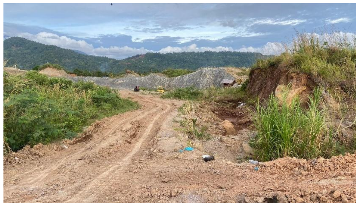
Gambar 1. Kondisi Jalan Gunung Sarik
