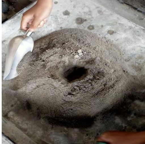
Gambar 4. 2 pencampuran agregat dengan semen (Sumber: Dokumentasi Pribadi)
