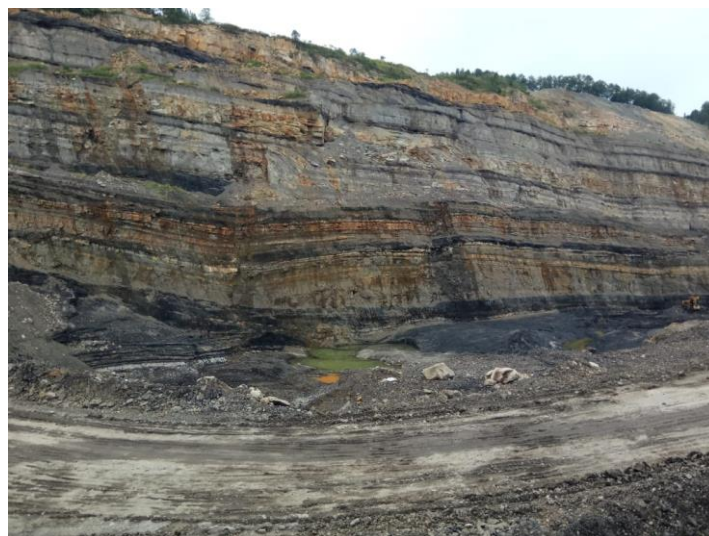
Gambar 1. Kondisi Lereng di Pit Barat PT. AICJ
