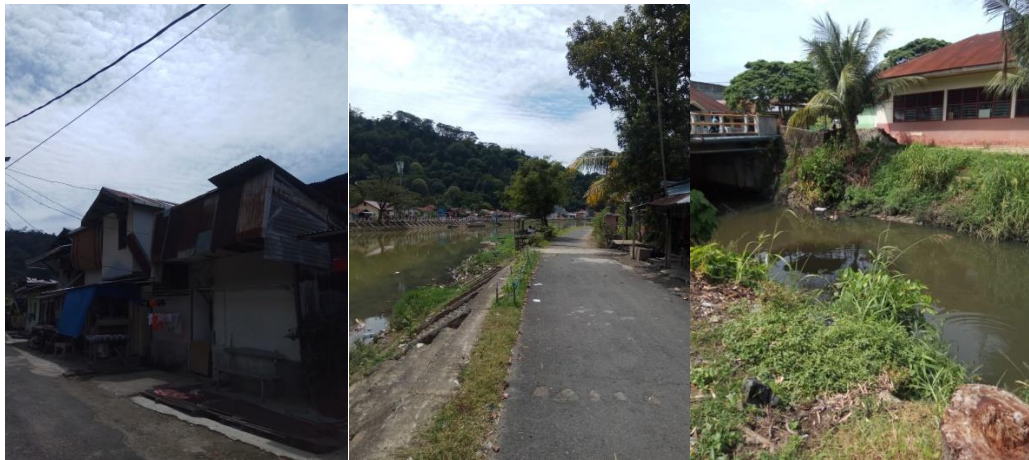
Gambar 23. Permukiman Kumuh di Bantaran Sungai Sumber: Dok. Rini Tanggal 28 Februari
