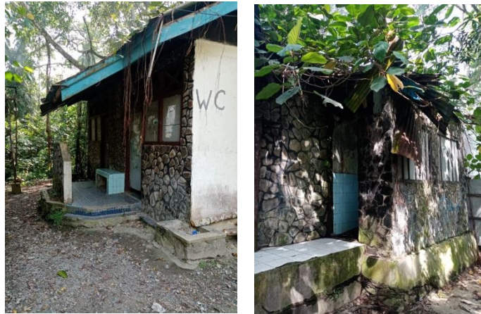
Gambar 3. Toilet Umum Sumber: Dokumen Pribadi 2020
