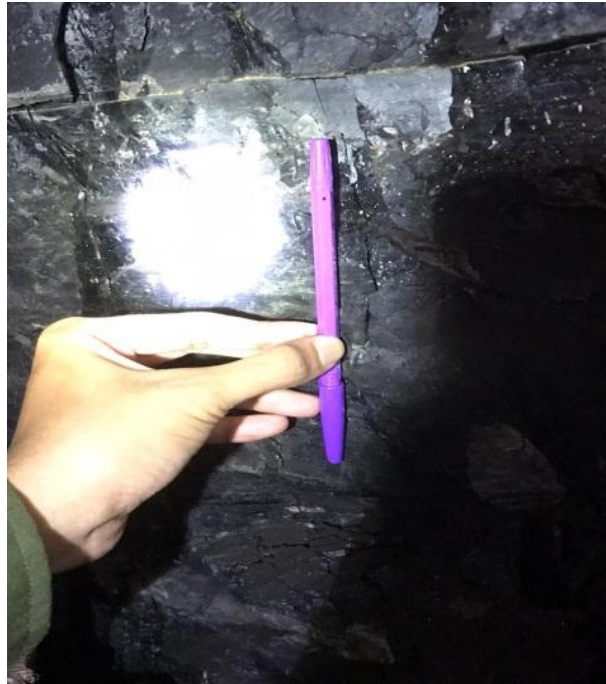
Gambar 3. Kekar Pada Dinding Tunnel THC 04
