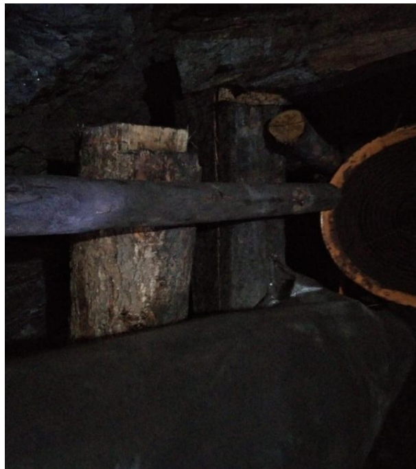
Gambar 1. Kayu Penyangga yang Retak pada Tunnel THC 04
