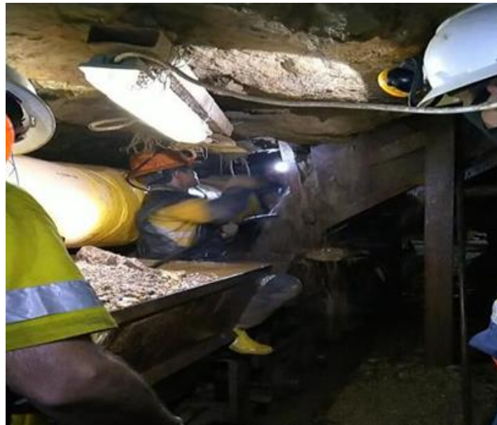
Gambar 1. Kegiatan Pemuatan Ore Pass Pada Chute Yang Telah Disiapkan
