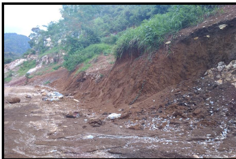
Gambar 1. Longsor yang terjadi pada lokasi jalan penambangan
