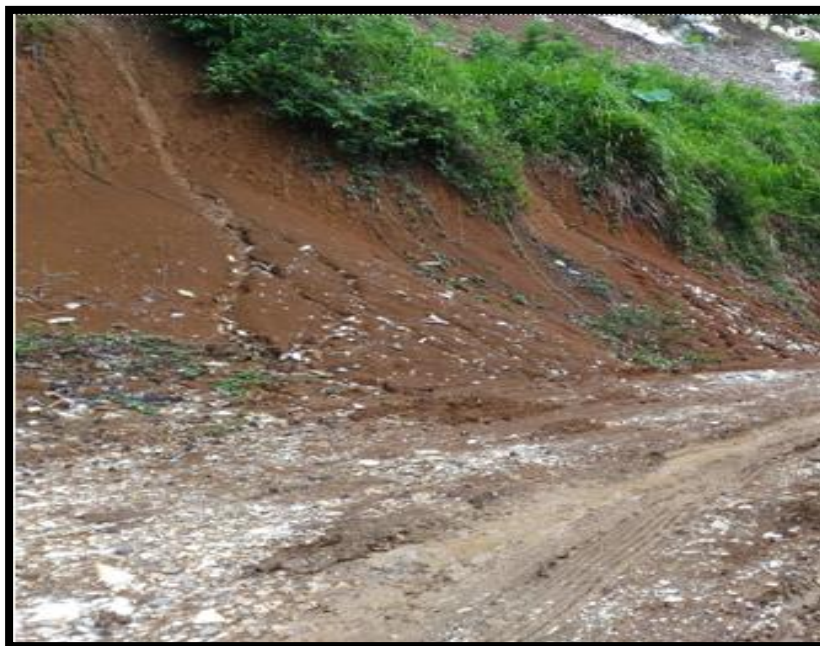
Gambar 2. Bekas aliran air pada bagian bench lereng
