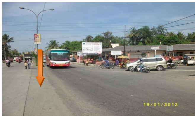
Gambar V.5 Kondisi Jalan Raya Lubuk Kilangan tanpa adanya median jalan diambil tanggal 19/01/2012
