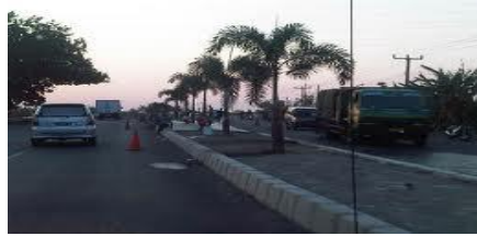
b. Pulau jalan
