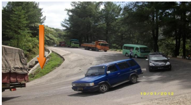
Gambar V.10. Kondisi Tikungan yang tajam pada Jalan Raya Panorama I diambil tanggal 19/01/2012
