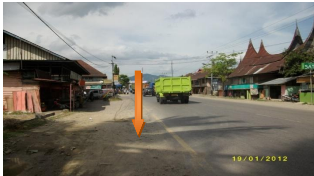
Gambar V.13 Kondisi jalan Raya Solok Padang Km.8 tanpa adanya bahu jalan dan marka jalan yang jelas diambil tanggal 19/01/2012
