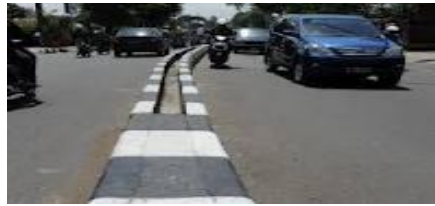
c. Beton pemisah
