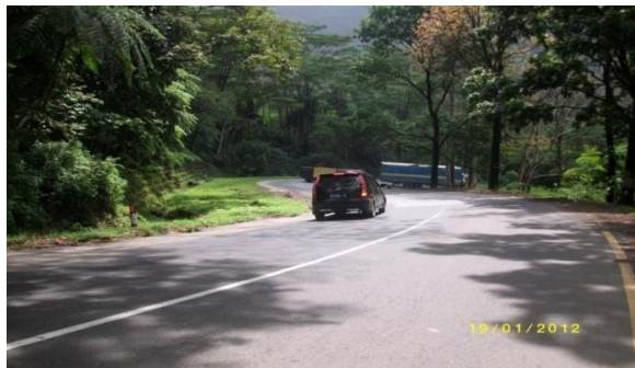
Gambar V.9 Kondisi Jalan Raya Padang – Solok Km.23 tanpa di lengkapi Rambu-Rambu Lalu Lintas diambil tanggal 19/01/2011
