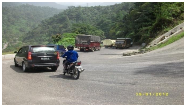
Gambar V.15 Kondisi Jalan Raya Solok Padang tanpa adanya Rambu-Rambu lalu lintas diambil tanggal 19/01/2012.
