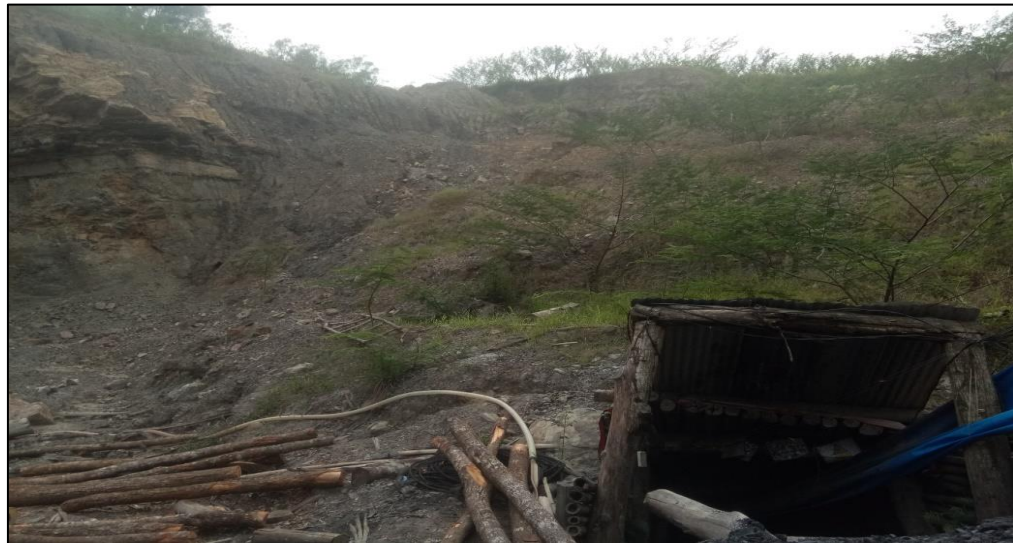
Gambar 1. Kondisi Lereng pada mulut tambang dalam BT 02 PT. Nusa Alam Lestari
