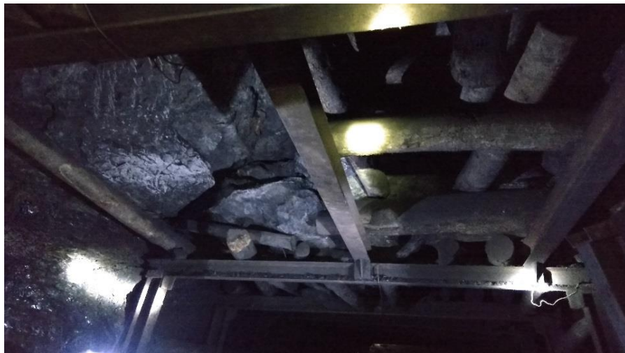
Gambar 1. (a) Kondisi penyangga kayu yang bengkok, (b) Batuan yang menggantung pada atap lubang bukaan.
