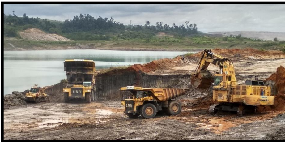
Gambar 4. Fleet Penggalan Material Lunak dengan Excavator PC 2000
