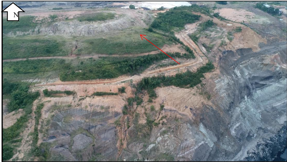
Gambar 2. Timbunan Material Disposal Pada sisi Timur Highwall Pit ABC
