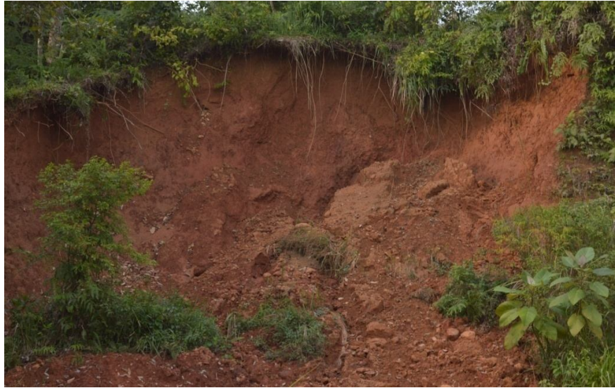
Gambar 8: Longsor DAS Batang Kuranji ( Sumber: Dokumentasi Pribadi )
