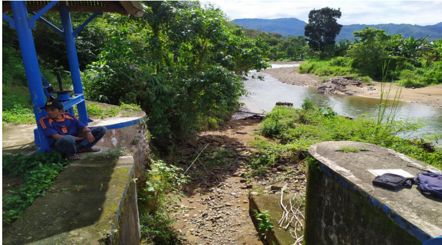
Gambar 15. Bendungan Kasang II yang tertutup oleh sedimen
