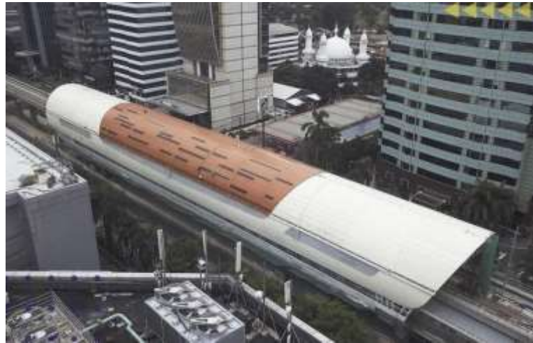
Gambar 2. Stasiun LRT Rasuna Said (Sumber: Dokumen Proyek)
