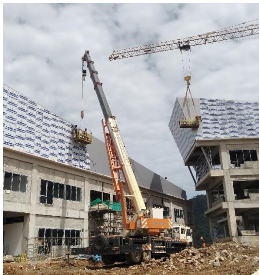
Gambar 1. Mobile Crane dan Tower Crane sebagai Pesawat Angkat. Sumber: Dokumentasi Pribadi
