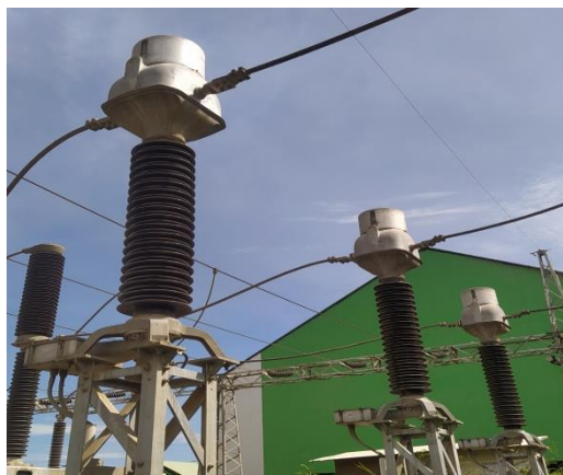
Gambar 3. 11 Trafo Arus Pemasangan Luar Ruangan
