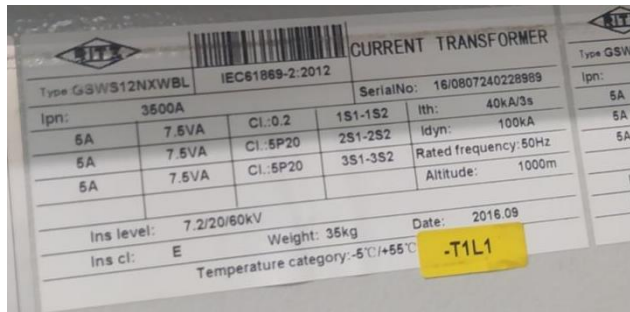
Gambar 4. 7 Rasio CT Pada Sisi 6,3 kV
