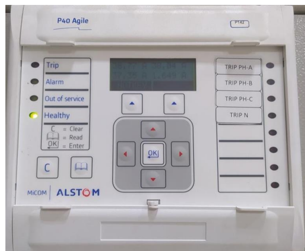
Gambar 3. 21 Relay Gangguan Tanah Terbatas
