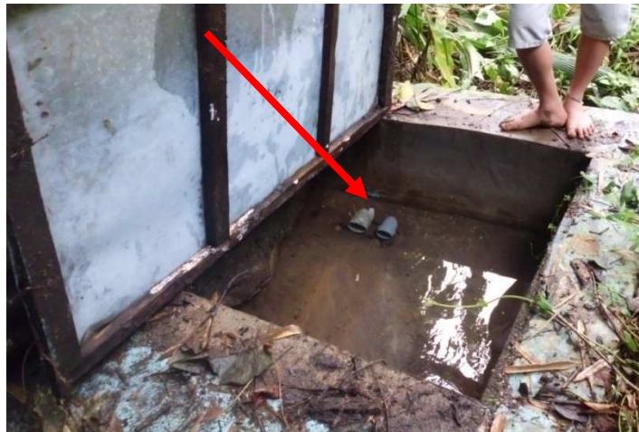
Gambar V.4. Mataair Aie Manambuak Batu I Dimanfaatkan Secara Gravitasi untuk Pemenuhan Keperluan Air Domestik Nagari Koto Baru (Sumber: Dokumentasi Pribadi, Juli 2012)
