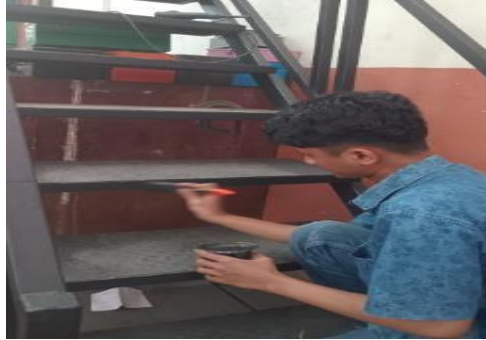
Gambar 4.13 Proses Pengecatan
