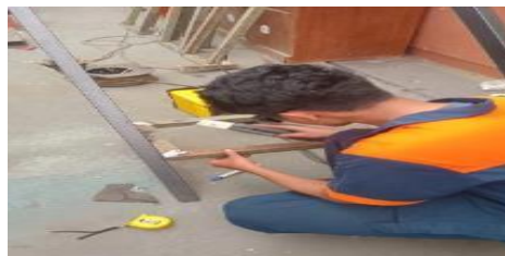
Gambar 4.9 Pengelasan Rangka Anak Tangga ke Tiang Jalur Tangga
