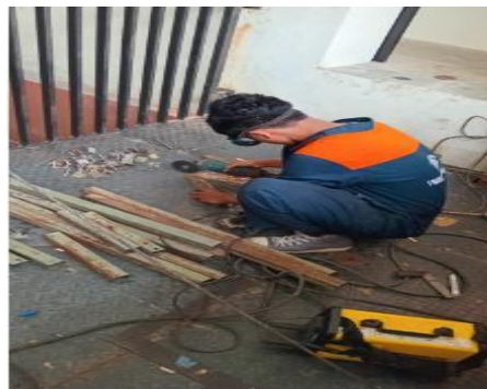
Gambar 4.5 Penyambungan Rangka
