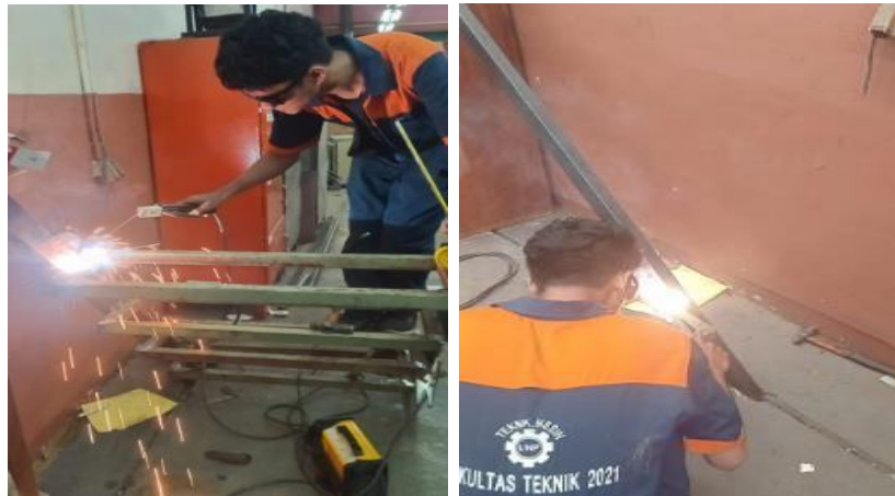
Gambar 4.10 Proses Pengelasan Penuh ke Tiang Jalur Tangga
