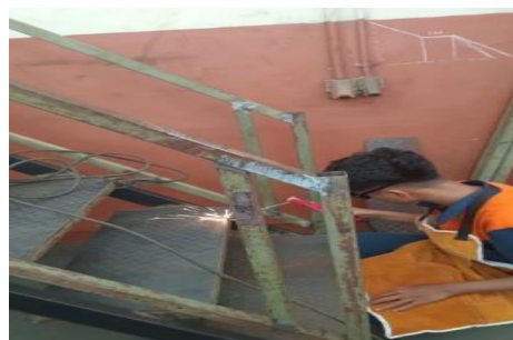
Gambar 4.12 Proses pengelasan plat bordes dengan rangka
