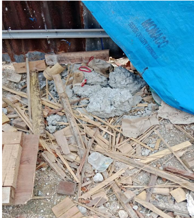
Material sisa semen dibuang di area proyek dapat menyumbat aliran air
