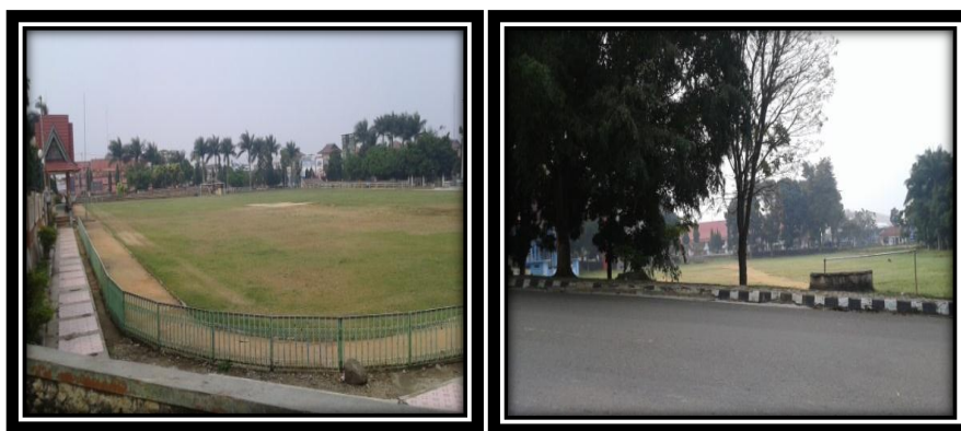
Gambar 41 . Kondisi Lapangan Olahraga Kota Sungai Penuh
