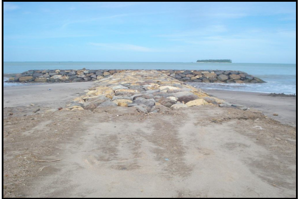
Gambar 1. Groin tipe T (R 43) (Sumber: Dokumentasi penulis)
