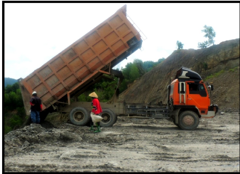
Gambar 4. Penimbunan Tanah Penutup
