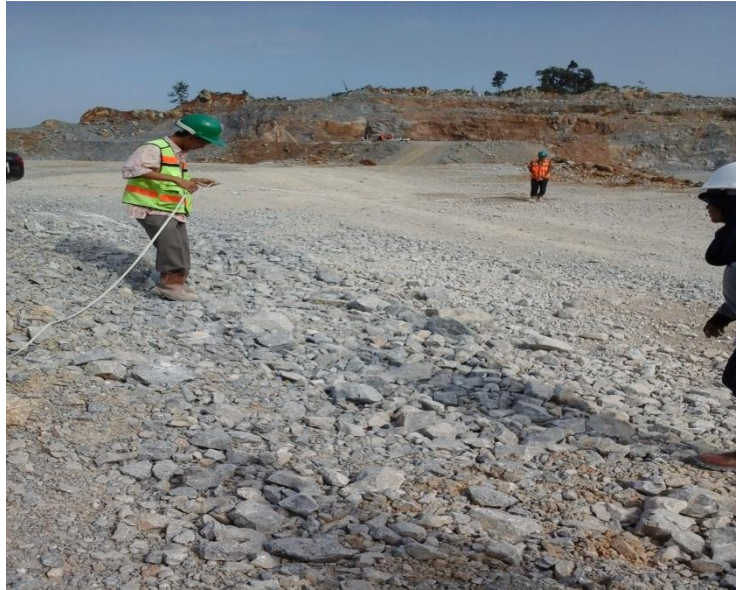
Gambar 7. Pengukuran Burden dan Spasi
