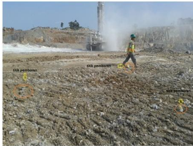
Gambar 8. Pemberian titik tanda bor
