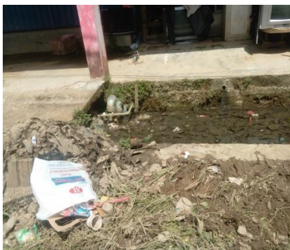
Gambar 1.1 Penumpukan sampah pada riol
