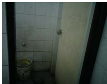
Gambar 4. Toilet yang kurang bersih
