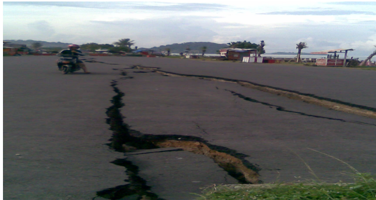
Gambar 2.7. Retaknya Tanah di Pantai Purus VI Padang Akibat Gempa 30 September 2009
