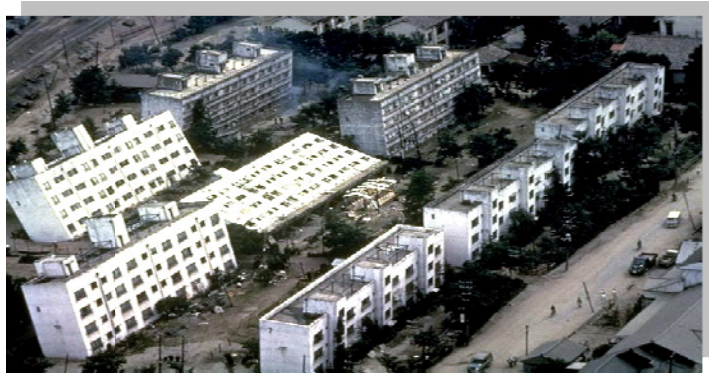
Sumber Dokumentasi Mercicorps-KOGAMI Gambar 2.5. Akibat dari Pelulukan di Thailand (Liquifaksi)
