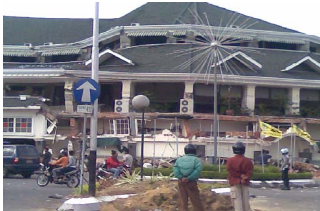
Sumber Dokumentasi pribadi Gambar 2.6. Runtuhnya Hotel Ambacang yang Menimbulkan Korban Jiwa Akibat Gempa 30 September 2009
