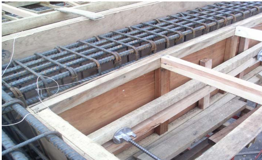
Gambar 20: Pemasangan Bekisting Balok Sumber : Dokumentasi Praktek Lapangan Industri
