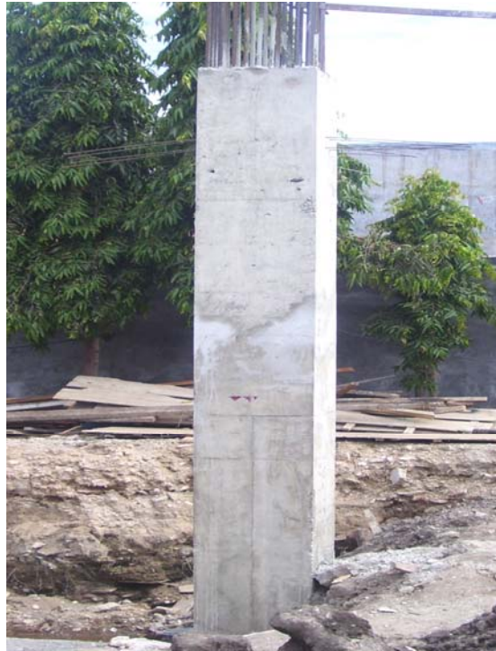
Gambar 17: Kolom Struktur Sumber: Dokumentasi Praktek Lapangan Industri
