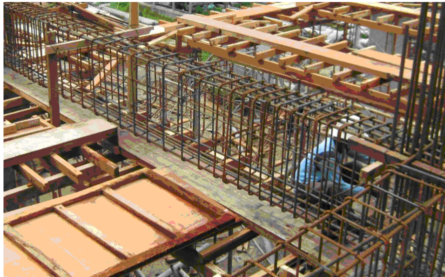
Gambar 19 : Pembesian Balok Sumber : Dokumentasi Praktek Lapangan Industri
