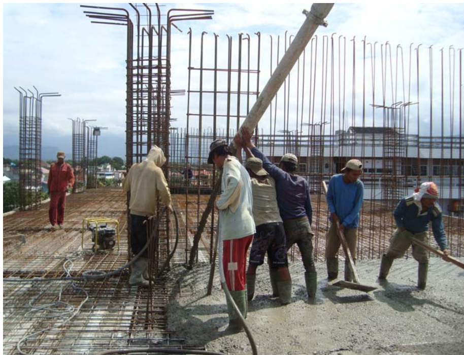
Gambar 22 : Pengecoran Balok dan Pelat Lantai Metal Deck
