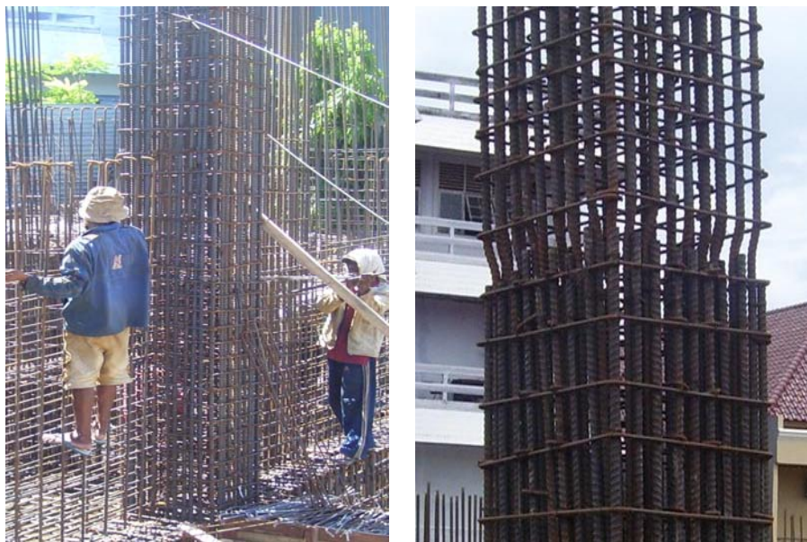
Gambar 14: Penulangan Kolom dan Sambungan Kolom ( Overlapping ) Sumber: Dokumentasi Praktek Lapangan Industri
