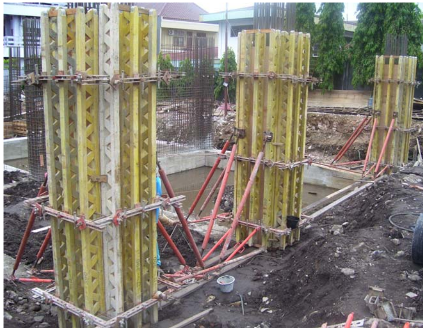
Gambar 15: Pemasangan Bekisting Peri-Lico Pada Kolom Sumber: Dokumentasi Praktek Lapangan Industri
