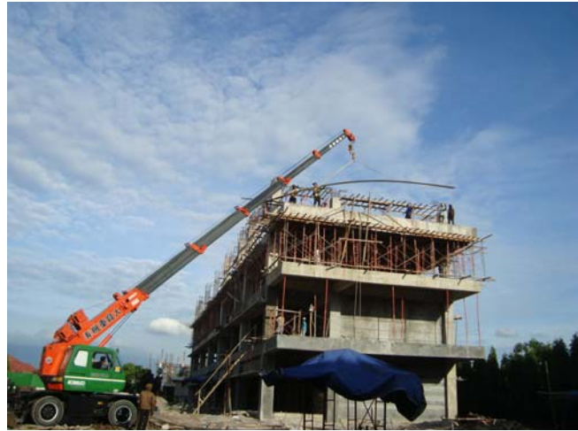
Gambar 12: Mobil Crane Sumber: Dokumentasi Praktek Lapangan Industri
