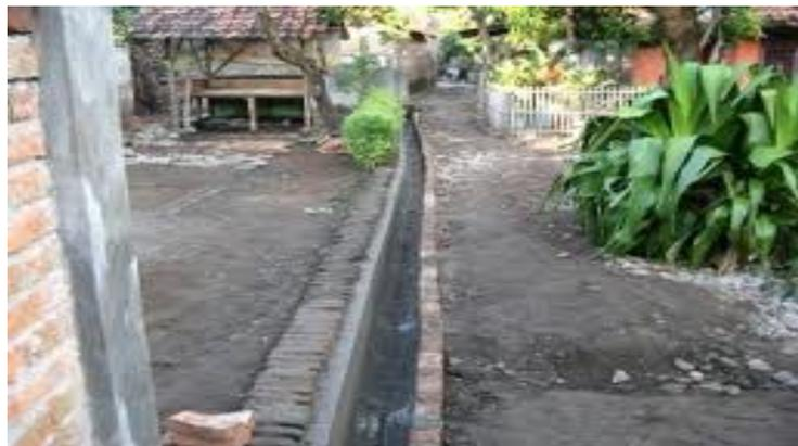
**Gambar 5** : Saluran Limbah Mandi, Cuci yang dibuat dengan Semen dan Batu Bata di Salurkan Langsung ke Got atau Parit (28 November 2010)
