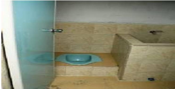
Gambar 3 :Tempat WC/kakus Permanen yang berbentuk Leher Angsa Terletak di dalam Rumah yang di Bersihkan 2 minggu sekali di Kecamatan Siak (28 November 2010)
