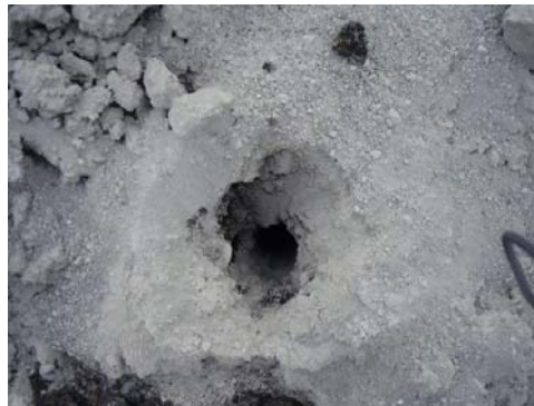
Gambar 12 : Hasil dari lubang bor yang berdiameter 3 inci
