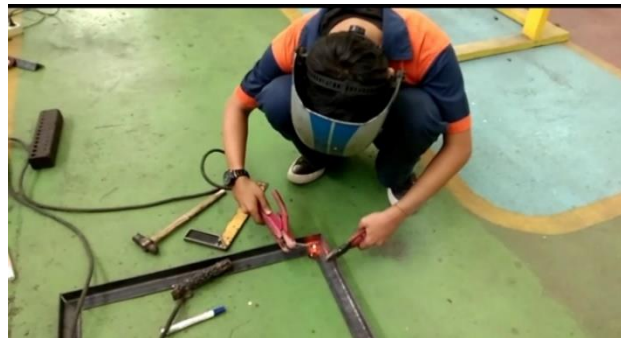
Gambar 4.4 Pengelasan Rangka (Sumber Workshop Fabrikasi UNP)
