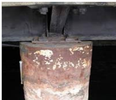
Gambar 6. Contoh Korosi Galvanik (mechanicalviancom)
