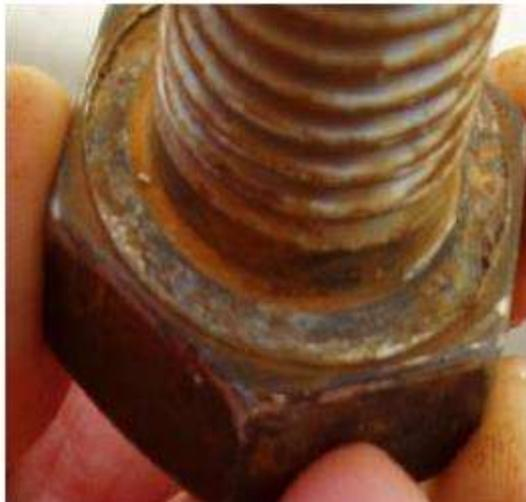
Gambar 3 *Crevice corrosion* (korosi celah) pada baut.
