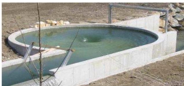
Gambar 11. Aliran *vortex* pada Rumah *Water Vortex Turbine*
