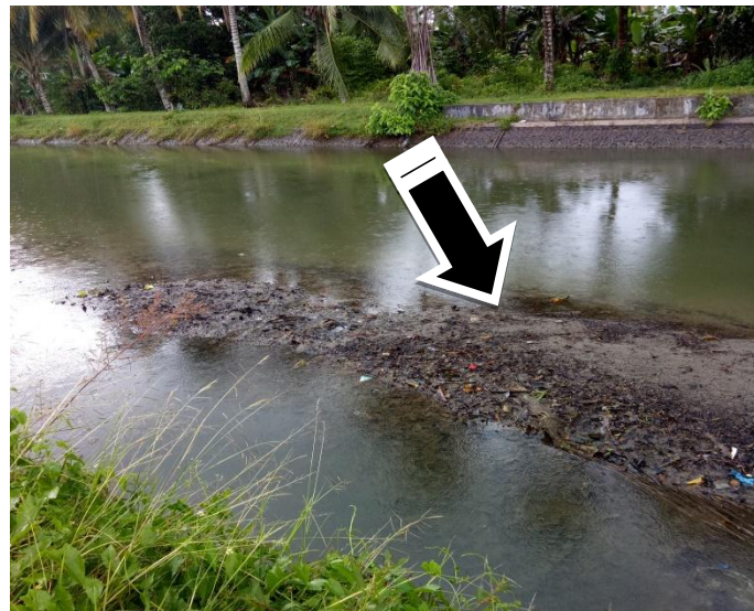
Gambar 1: Penumpukan Sedimen di Saluran Primer (Sumber : Dokumentasi Pribadi)
