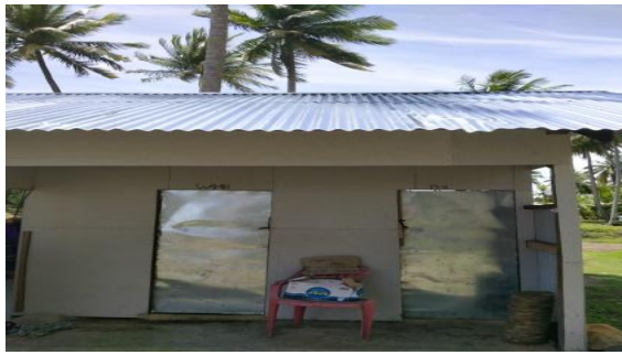
Gambar 2. Toilet yang ada di Objek Wisata Buayo Putih Sumber: Dokumentasi Pribadi (2020)
